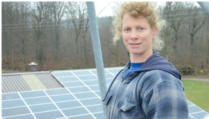
Anita Dubs installierte auf dem Dach ihrer Scheune eine Photovoltaik-Anlage, die jährlich fast 100000 Kilowattstunden Strom liefert. Quelle: fmi
