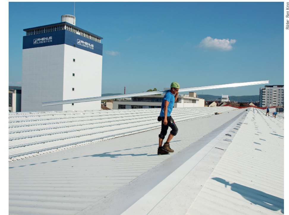
August 2011: Die Aluminiumschienen zur Montage der Photovoltaik-Anlage werden befestigt.
