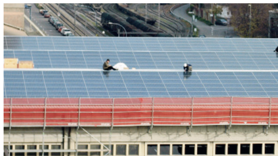
Nur wenige Wochen später: Sämtliche Module sind installiert. Die Anlage ist in Kürze betriebsbereit.
