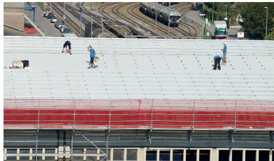
Fürs Erste werden nur die nach Süden geneigten Dachschrägen für die Montage der Solarmodule vorbereitet.
