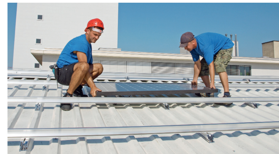
Montage der allerersten Solarzelle: Der Aufbau der Anlage selbst nahm sehr viel weniger Zeit in Anspruch als die Planung und Vorbereitung.
